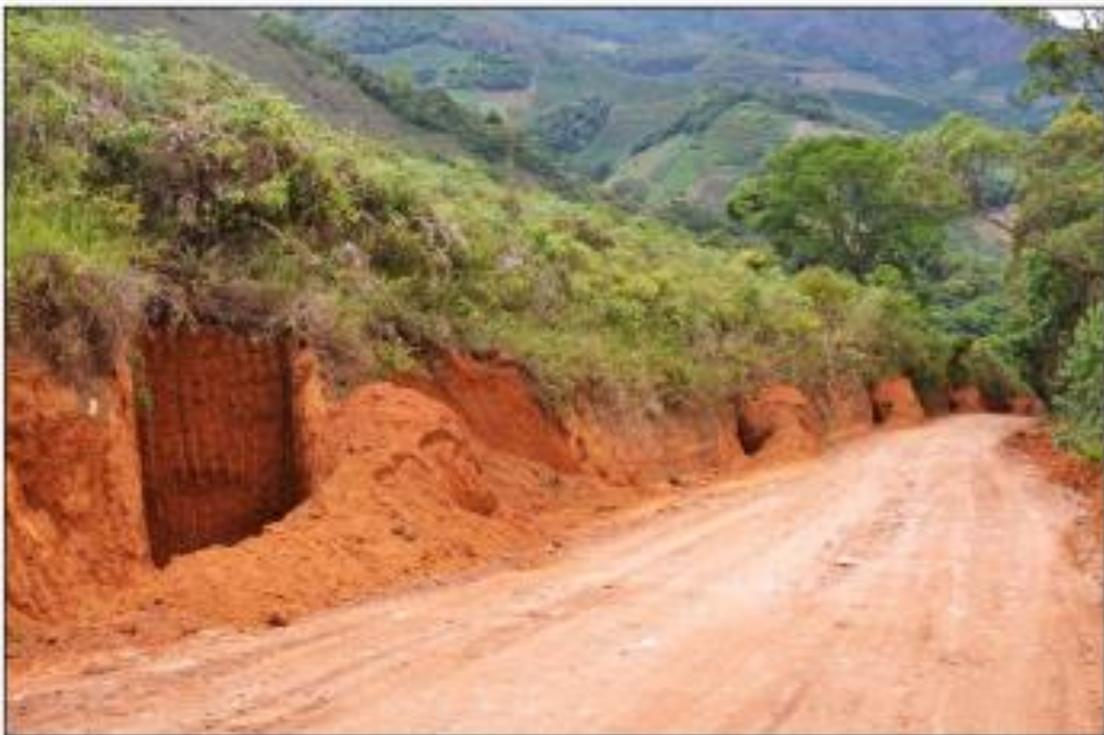
**Figura 11 (a e b) – Caixas secas em estradas declivosas e encaixadas do Espírito Santo (a) e Minas Gerais (b).**
