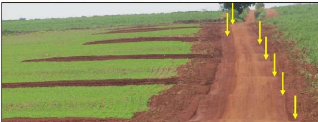
Figura 7(a e b) - Indicação dos camalhões em estradas readequadas no âmbito do Programa Produtor de Água: projeto Pípiripau-DF (a) e projeto Nascentes em Botucatu-SP (b).
